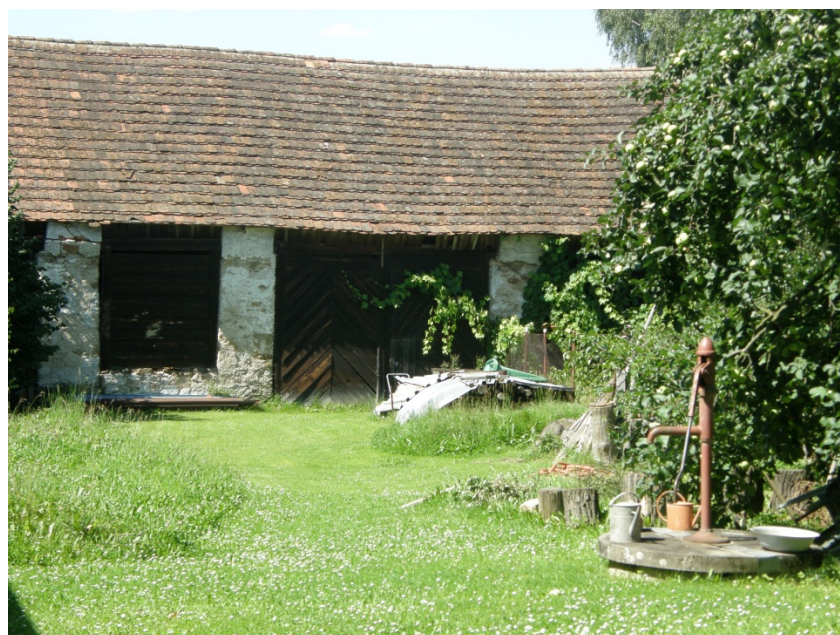
Křenovice č.p. 1 – bývalá rychtářská stodola
